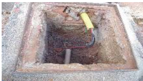
Foto 47 - Detalhe da caixa de passagem (elétrica), que deve receber uma camada de brita no fundo, evitando o contato direto entre condutores e umidade do solo
