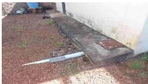
Foto 41 - Detalhe da calçada interna, caixa e ramal de esgoto do bloco de alojamentos dos fundos, sugerindo a ampliação da calçada e redirecionamento do esgoto
