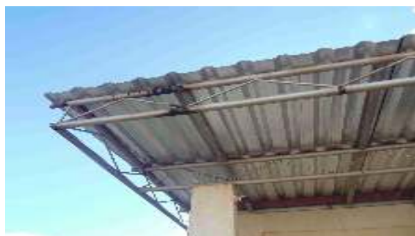
Foto 09 - Detalhe do telhado da varanda frontal, onde observam-se pontos danificados e pequenos trechos de novos perfis soldados ainda sem tratamento/pintura
