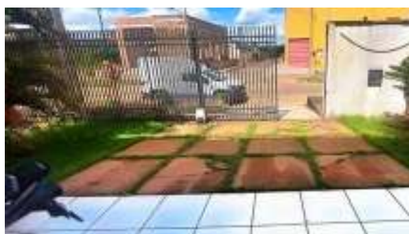
Foto 64 - Detalhe do piso da varanda e da rampa de acesso de pedestres, que apresentam boas condições, apesar de algumas placas de cimento comprometidas
