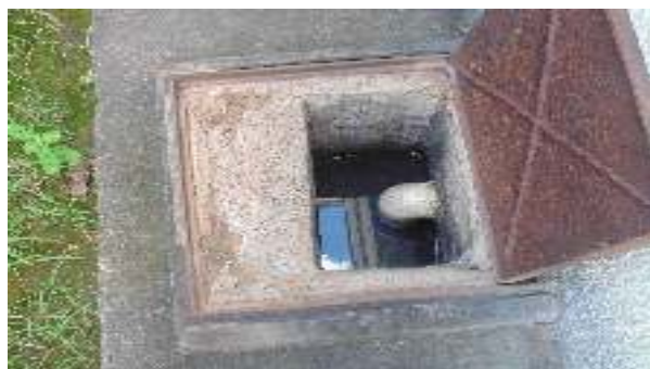
Foto 55 - Detalhe da caixa de gordura (cozinha), que demonstra boas condições de manutenção e limpeza, porém situada muito próxima à saída de águas pluviais
