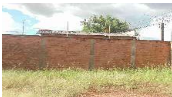
Foto 21 - Vista interna do muro lateral do lote, que demonstra uma aplicação superficial de chapisco em somente um pequeno trecho da alvenaria de tijolos
