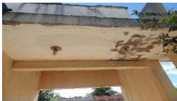
Foto 18 - Vista da laje em concreto armado acima da antiga Área Externa, onde se percebe a possibilidade de pontos de infiltração e degradação da laje existente
