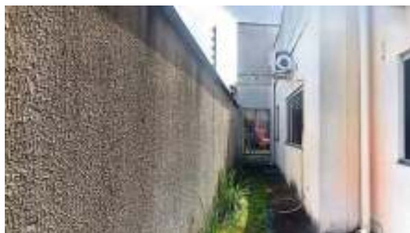
Foto 68 - Detalhe do muro (jardim lateral), revelando muitas manchas de pintura por ação das intempéries, sendo indicada a pintura texturizada com tinta acrílica
