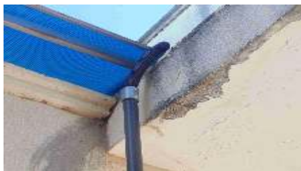
Foto 16 - Detalhe da fixação do eletroduto externo de aterramento da edificação, proveniente de serviços recentemente executados por empresa especializada
