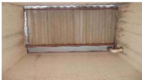
Foto 59 - Detalhe do telhado da antiga Área Externa, que revela manchas na pintura de todas as paredes e ausência de pintura nos perfis metálicos da estrutura
