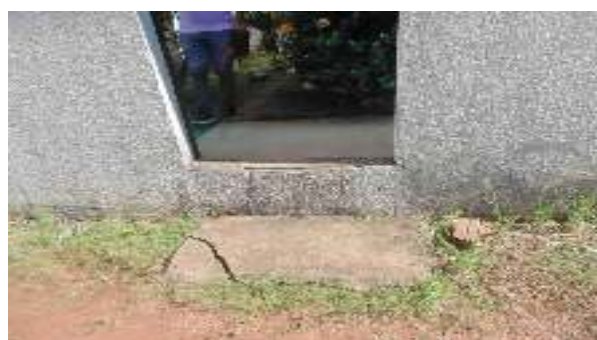
Foto 24 - Vista do portão de entrada lateral, onde se percebe um desnível de 48cm a ser superado por uma rampa integrada à calçada interna proposta (ver F. 17)
