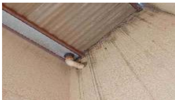
Foto 60 - Detalhe da calha, telhas e perfis metálicos da estrutura do telhado, que aparentava possibilidade de infiltrações próximas às paredes pela ausência de rufos
