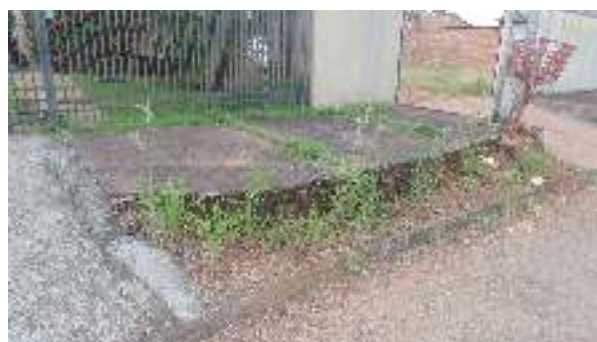
Foto 04 - Detalhe da calçada externa em frente ao portão central, que também deve ser demolida para nivelamento do passeio público e rampa de acesso
