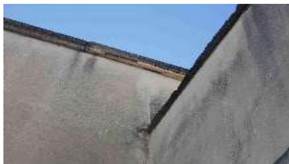
Foto 56 - Detalhe da platibanda do telhado junto ao gramado, cujas pingadeiras apresentam-se quebradas, sendo necessária substituição total e pintura externa
