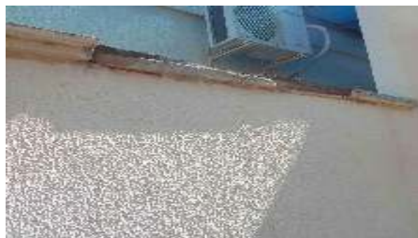
Foto 32 - Detalhe das pingadeiras instaladas no muro interno, que se apresentam completamente soltas ou danificadas, sendo necessária a substituição de todas
