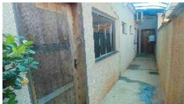
Foto 26 - Detalhe da porta de madeira do alojamento feminino, onde se observa a ausência de proteção com pintura interna e externa em verniz incolor (fosco)
