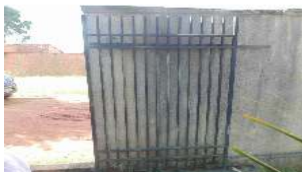
Foto 28 - Detalhe do portão de entrada lateral (gradil) que apresenta vão atual de 1,00m (largura), devendo ser 1,20m para oferecer acessibilidade ao público PNE
