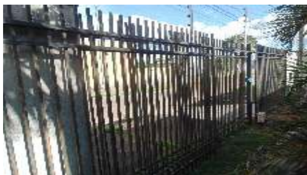
Foto 29 - Detalhe do gradil frontal do Edifício Sede da Regional Sul, que deve receber lixamento e pintura em tinta esmalte sintético com pistola (cor a ser definida)
