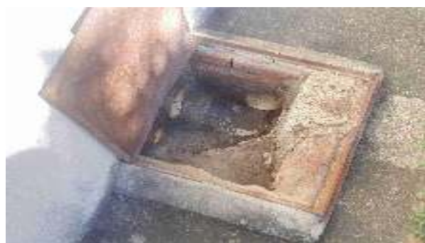
Foto 50 - Detalhe da caixa de esgoto mais próxima ao banheiro interno, devendo ser readequada em virtude do direcionamento do esgoto (bloco de alojamentos)
