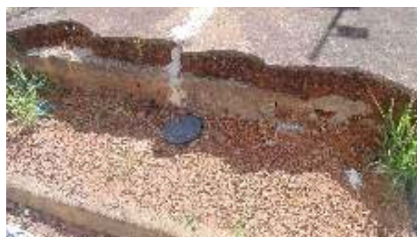
Foto 03 - Detalhe do piso cimentado a ser demolido para nivelamento do passeio público, considerando a caixa de aterramento do padrão de energia elétrica
