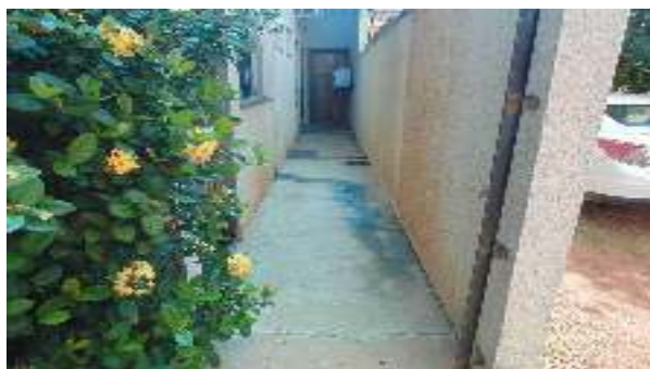
Foto 25 - Vista da circulação externa, que dá acesso aos alojamentos masculino/feminino, onde se percebe o desnível (48cm) em relação ao pátio/estacionamento
