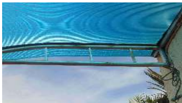
Foto 14 - Detalhe do apoio metálico de sustentação do toldo, sendo necessária apenas a padronização da pintura em esmalte sintético destas peças metálicas
