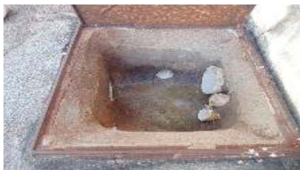
Foto 45 - Detalhe da caixa de esgoto mais próxima ao banheiro do bloco de alojamentos, a ser readequada para o redirecionamento do fluxo de esgoto sanitário
