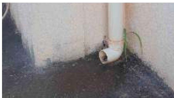
Foto 57 - Detalhe do trecho final do condutor vertical, onde se vê que as águas pluviais não são devidamente destinadas, possibilitando o acúmulo de água parada
