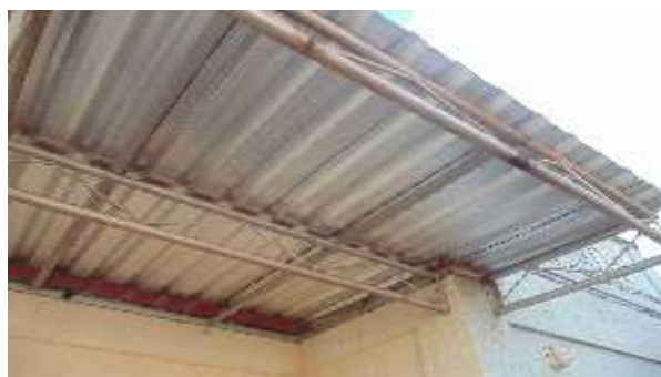
Foto 10 - Detalhe do telhado da varanda frontal, onde observam-se pontos danificados e pequenos trechos de novos perfis soldados ainda sem tratamento/pintura
