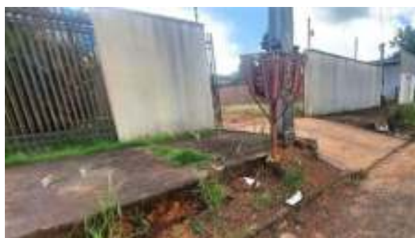
Foto 62 - Detalhe da calçada externa, demonstrando a total falta de acessibilidade do pedestre, bem como a exposição da base da lixeira e poste de energia elétrica
