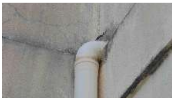
Foto 58 - Detalhe da platibanda e do trecho inicial do condutor vertical em perfeitas condições, fazendo-se necessária a execução de pintura em tinta acrílica
