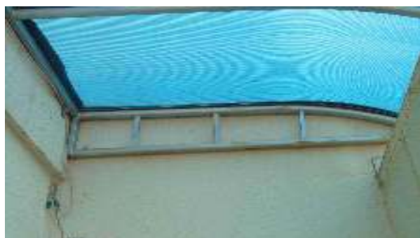
Foto 15 - Detalhe do apoio metálico de sustentação do toldo, sendo recomendada tratamento contra as intempéries e pintura em esmalte sintético das peças
