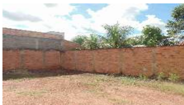
Foto 22 - Vista interna do canto do muro existente, mais especificamente do muro lateral e fundos do lote, que não apresenta nenhuma proteção contra umidade
