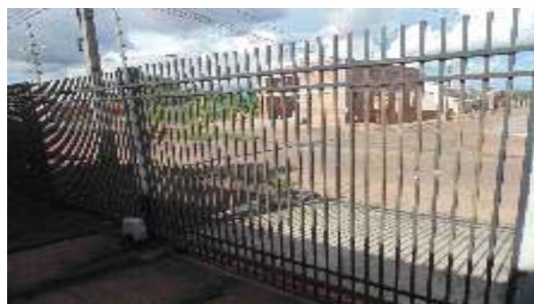
Foto 30 - Detalhe do portão/gradil frontal na rampa de acesso ao Edifício Sede da Regional Sul, onde se indica o mesmo tratamento com lixa e pintura pistola
